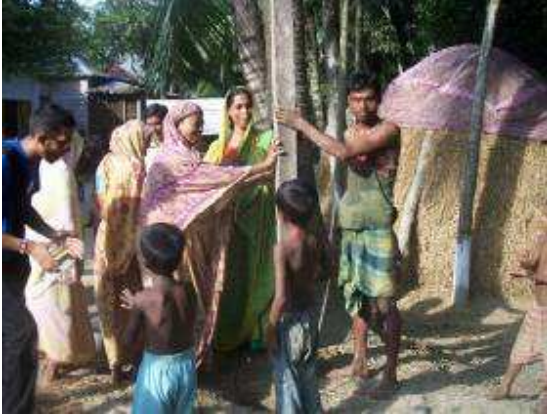
Grundpfeiler für das Community Centre werden errichtet
