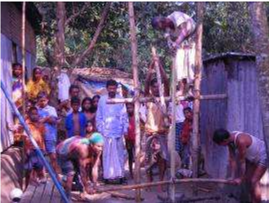
Die Dorfgemeinschaft packt an: Installation der ersten Wasserpumpe in Ajmotpur
